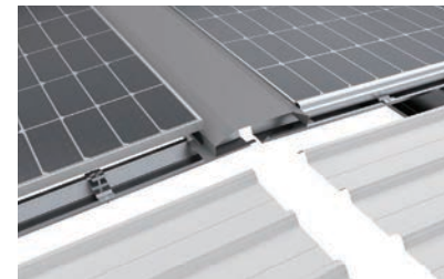
屋脊盖板安装
