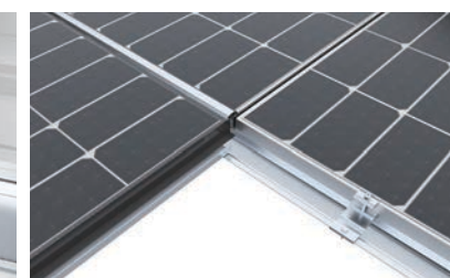
防水盖板安装
