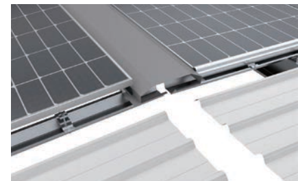
屋脊盖板安装
